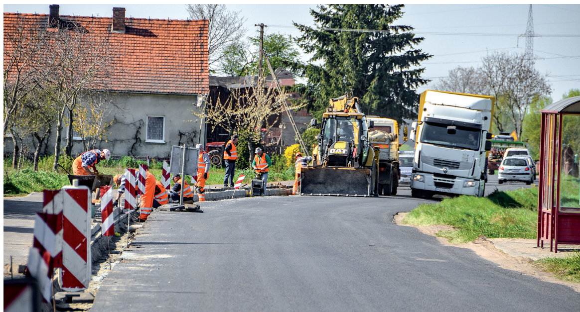
▲ Gostyński Drogbud wykonuje prace przy przebudowie drogi powiatowej Mórkowo – Wilkowice. Wykonawcy proszą kierowców o wyrozumiałość i ostrożną jazdę.
