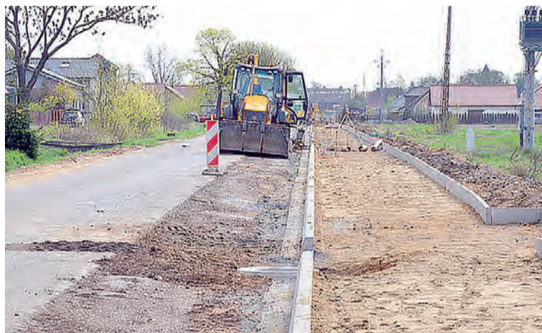
Budowa ścieżki rowerowej w Dąbczu jest już mocno zaawansowana.
