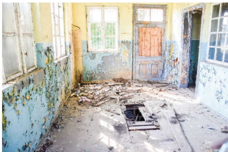
▲ Tutaj podróżni nie mieli wstępu. Szkoda, że nie zachowały się urządzenia nastawiczne zamontowane niegdyś nad widoczną dziurą w podłodze.
