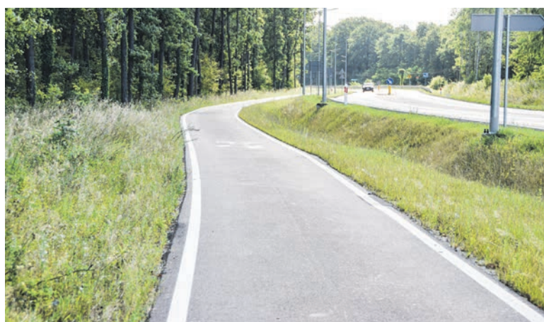
▲ Jadąc do Górzna nad jezioro można zaplanować trasę z wykorzystaniem nowej ścieżki rowerowej wzdłuż drogi krajowej nr 12, na odcinku od Kąkolewa do Garzyna.
