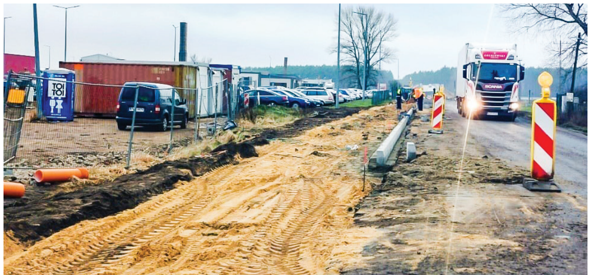
▲ W ciągu najbliższych miesięcy zmodernizowana zostanie droga powiatowa przebiegająca przez Kłodę. Projekt przewiduje również wybudowanie ścieżki rowerowej.
