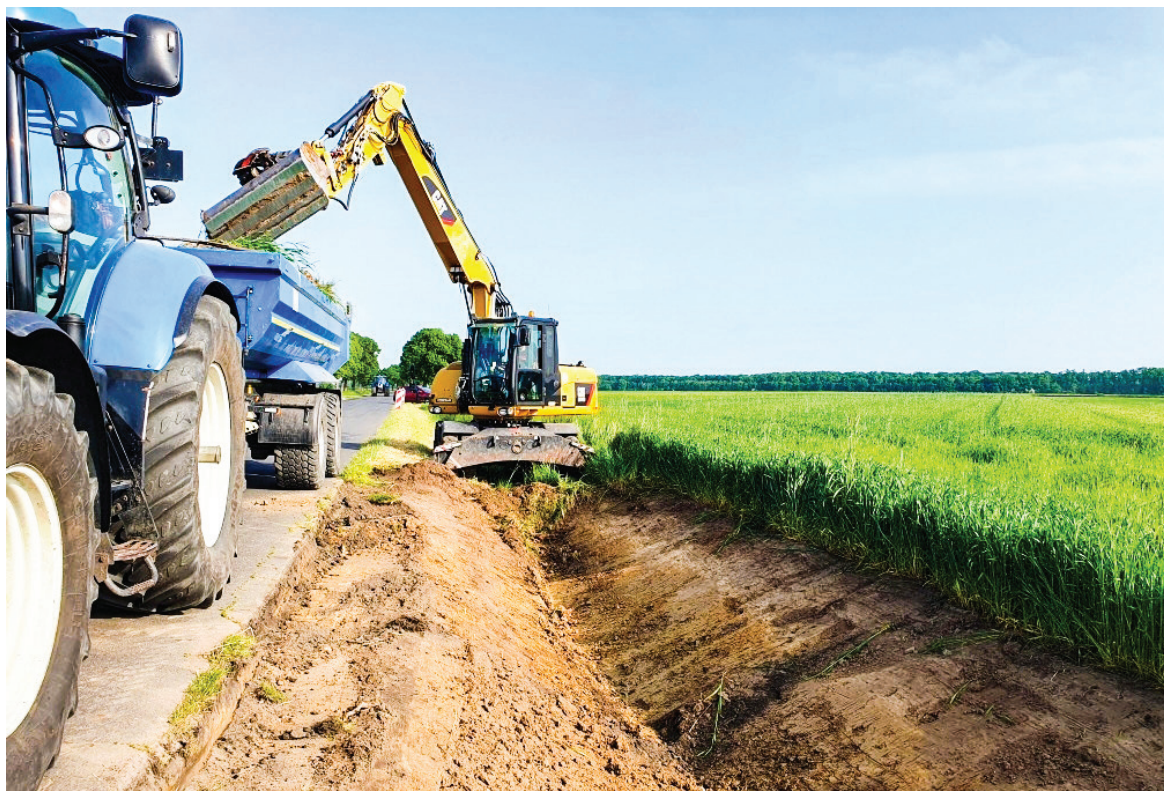
▲ W minionym tygodniu rozpoczęto przebudowę drogi od drogi krajowej nr 12 do Pawłowic.
