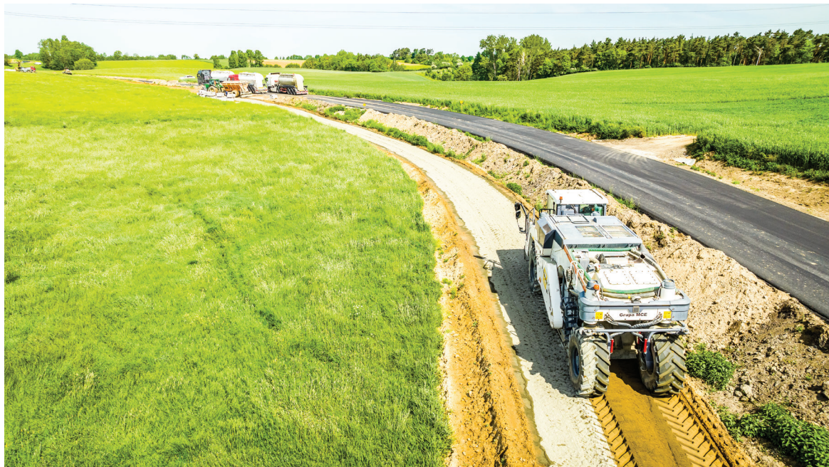
▲ Prace przy przebudowie drogi Goniembice - Osieczna są już mocno zaawansowane.
