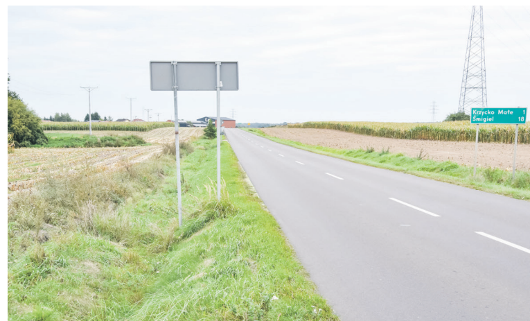
▲ Jeszcze w tym roku wybudowana zostanie ścieżka rowerowa od drogi powiatowej Leszno – Włoszakowice do Krzycka Małego.
