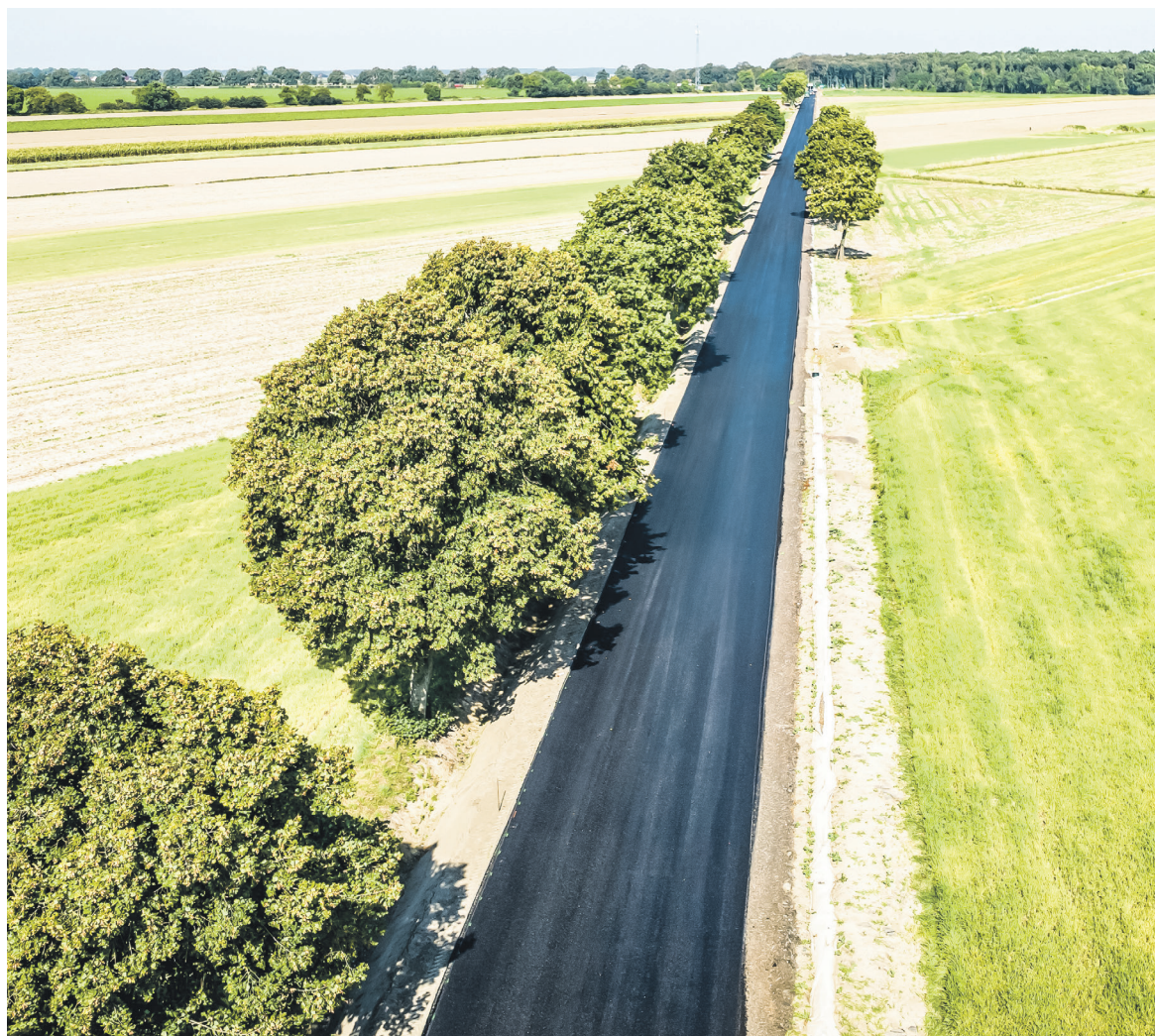
▲ W ramach przebudowy drogi od krajowej "12" do Pawłowic budowana jest ścieżka rowerowa.
