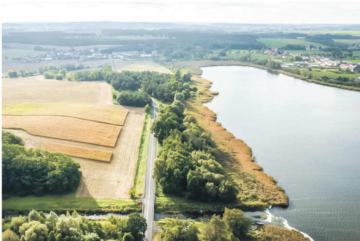
▲ Droga powiatowa w Wojnowicach.
