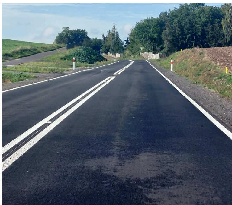
▲ Droga powiatowa Osieczna - Goniembice.
