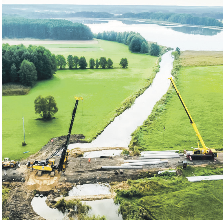
▲ Budowa mostu na drodze powiatowej Brenno - Miastko.
