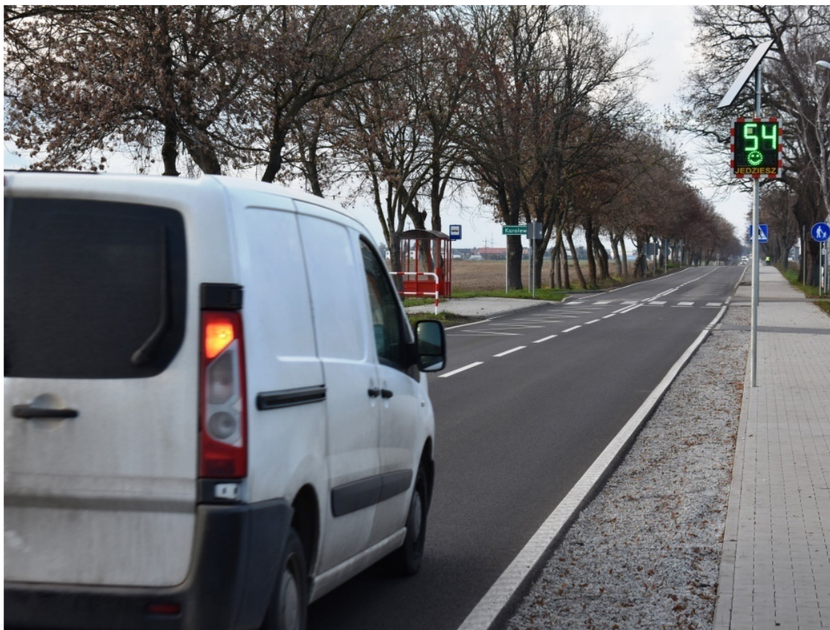
▲ Ulica Mórkowska łącząca Wilkowice z drogą wojewódzką nr 309 ma teraz 6 metrów szerokości. Przed przejściem dla pieszych, kierowców do zdjęcia nogi z pedału gazu, zachęca radar z wyświetlaczem prędkości jazdy.
